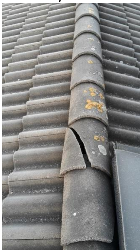
Bild 9. Trasigt nocktegel.
