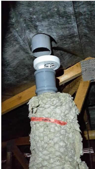
Bild 19. Avloppsavluftningarnas genomföringar har ersatts med vakuumventiler.
