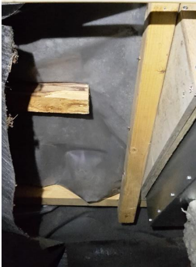
Bild 15. Genomföring för toppventilator dåligt utförd.
