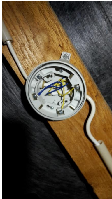
Bild 17. Pluggad genomföring byggd av spånskiva som svällt och möglat.
