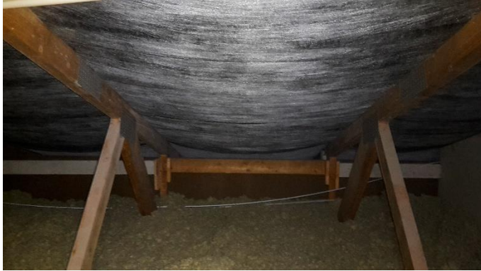
Bild 12. Största delen av yttertaket har frihängande underlagsfilt.
