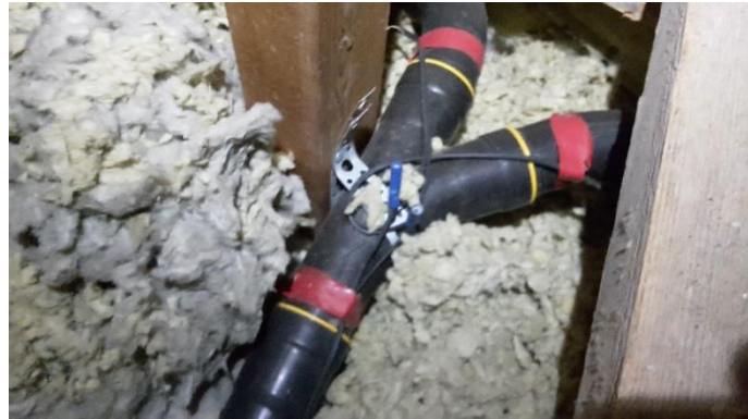
Bild 19. Avloppsavluftningarnas genomföringar har ersatts med vakuumventiler.
