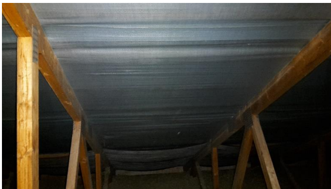
Bild 13. Nordöstra delen av byggnaden har armerad plast.
