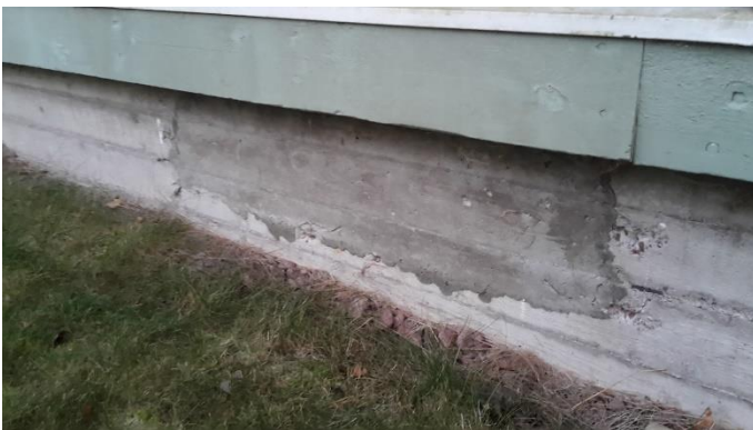
Bild 6. Gammalt dörrhål som gjutits fast på norra sidan.
